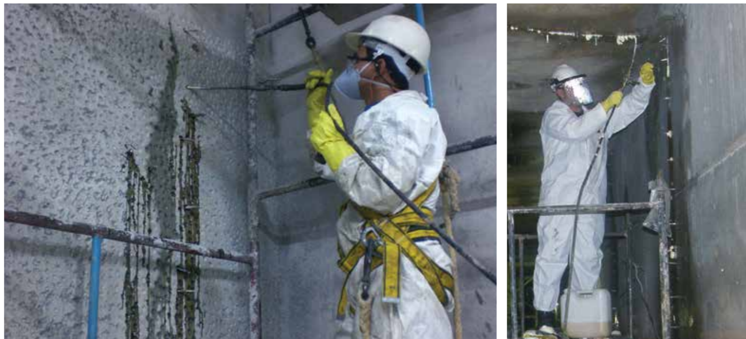
MASTERPUR GEL 2CF32 e MASTERPUR HIDROATIVO 2CF10: utilizados em larga escala no Complexo Hidrelétrico Simplício.
